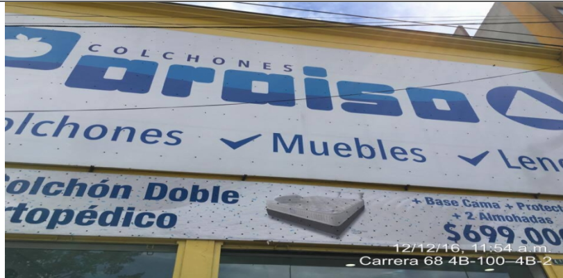
Fotografía No. 1 Elemento de publicidad tipo Aviso en Fachada, instalado en fachada del establecimiento de comercio ubicado en la Avenida Carrera 68 No. 4B - 50, el cual no cuenta con registro
